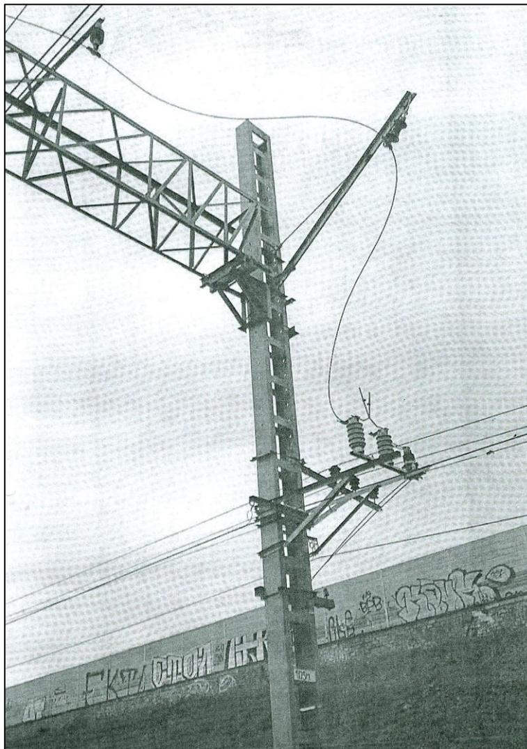
После приближения люлек к опоре другой электромонтёр-линейщик перешёл на опору и стал спускаться. Электромонтёр-линейщик 1 вышел из люльки на стрелу крана (так как его люлька была дальше от опоры), чтобы перейти по кронштейну разрядника ОПН (ограничитель перенапряжения) на опору. Стоя на стреле крана, держась одной рукой за ограждение люльки, другой рукой электромонтёр-линейщик 1 взялся за перемычку ОПН, подключённого к действующему III пути, и был поражён электрическим током.
